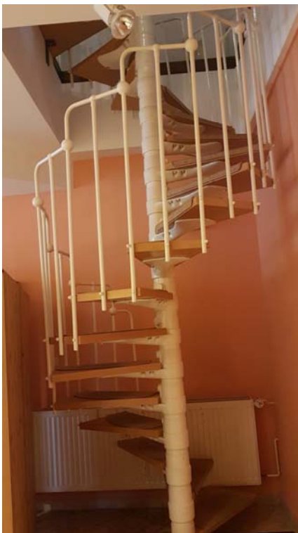
Bild 4: Spindel-treppe zum Obergeschoss
