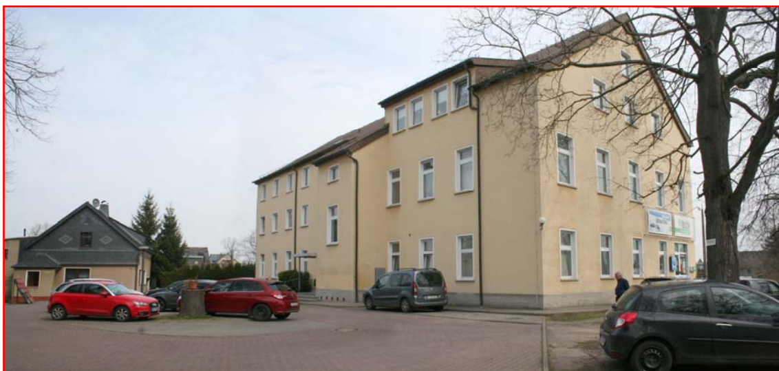
Rückansicht Gebäude mit Parkplatz
