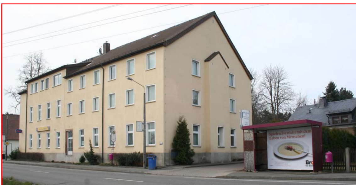
Gebäudeansicht Waldenburger Straße mit Parkplatzzufahrt und benachbarter Bushaltestelle
